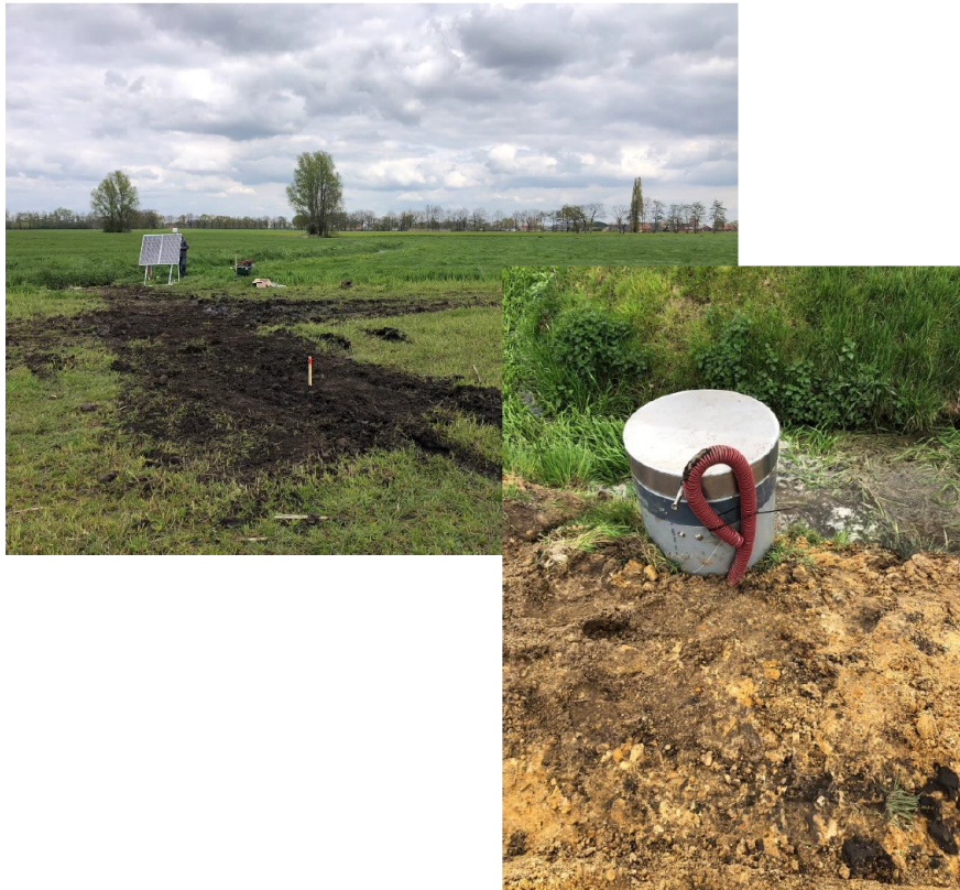
Figure 4: Uitvoering op het terrein (l) zonnepanelen energievoorzieningen en (r) controleput met balg in Essen, België
